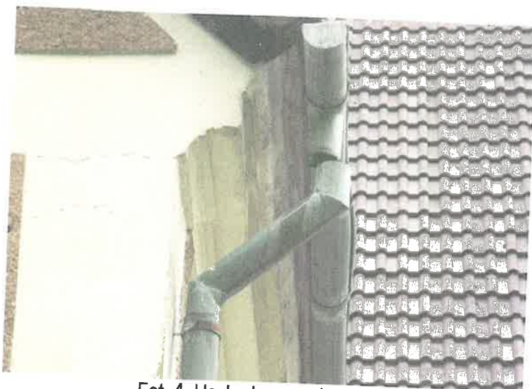
Fot. 4. Uszkodzone połączenie
